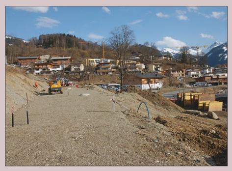
Im Bereich Sonngrub-West laufen die Vorbereitung für den neuen Siedlungsbereich bereits wieder auf Hochtouren. Derzeit wird an der Wegerschließung sowie Kanalisierung und Anbindung an das Stromnetz gebaut. Bis Mitte Mai dürften diese Arbeiten fertig gestellt sein. Insgesamt entstehen in diesem Bereich 19 neue Baugrundstücke, wobei zehn bereits an einheimische Familien verkauft wurden. Für weitere sieben Grundstücke gibt es eine Vergabe-Zusage, die zwei restlichen sind noch frei.
