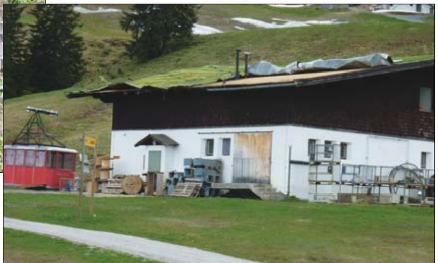
*Der Föhnsturm in der Woche vor Pfingsten hinterließ in der Höhe Spuren. Das Dach der ehemaligen Talstation des seinerzeitigen Zwillingliftes Streiteck wurde schwer beschädigt, die blecherne Eindeckung sogar teilweise abgetragen. Die 1960 errichtete Anlage stellte damals eine Novität dar, mehrsitzige Einzelanlagen gab es noch nicht (siehe hiezu Stadtzeitung Ausgabe November 2012, S. 16).*
