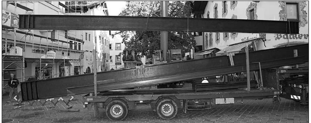
*Die Stahlträger sind bis zu acht Meter lang und fünf Tonnen schwer.*
