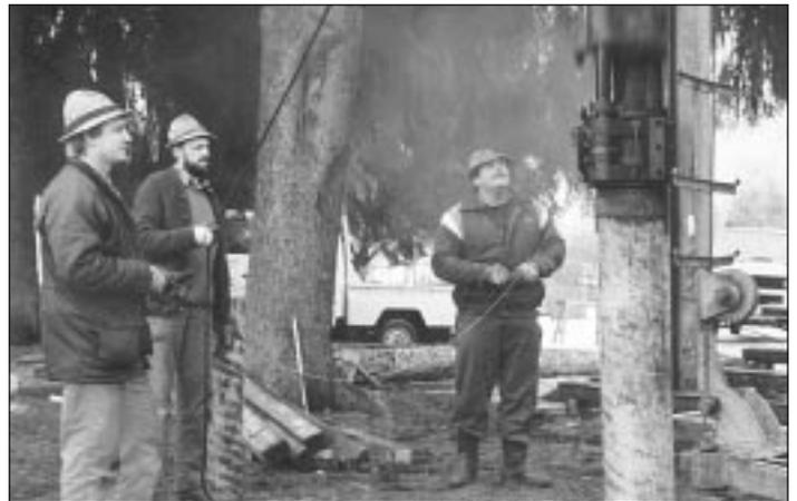
Bild rechts unten: Pilotenschlagen am Schwarzsee.
