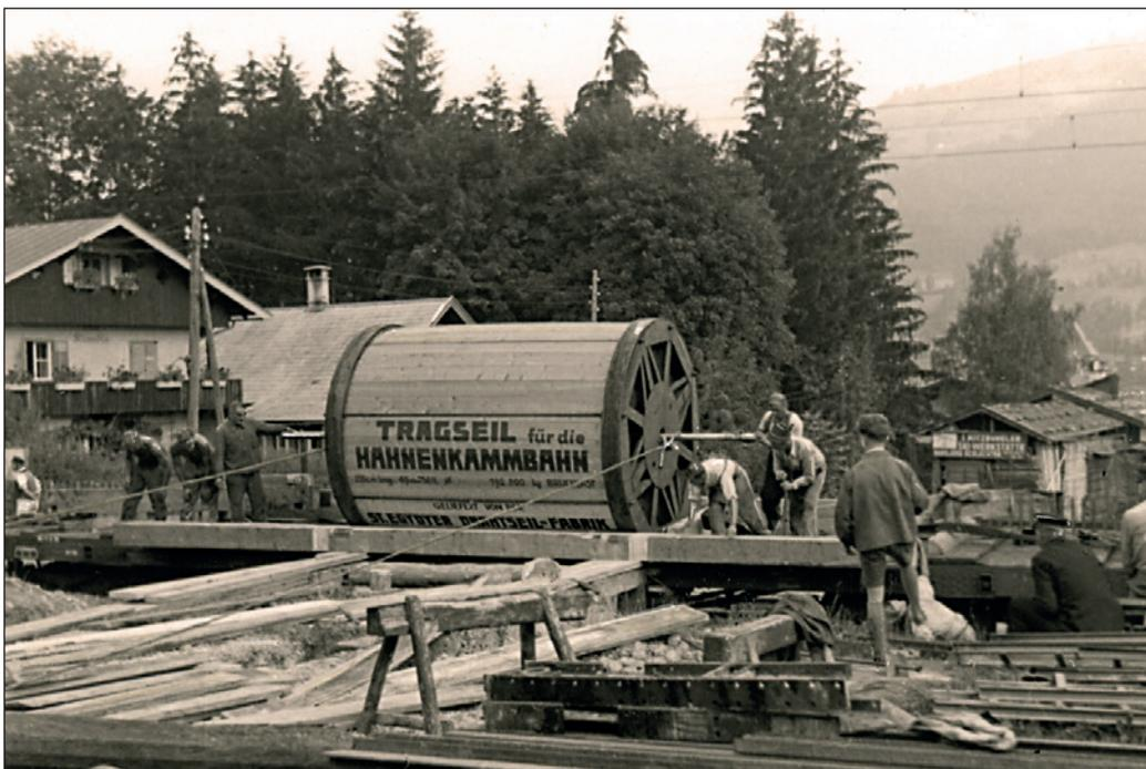
*Für die Anlieferung des Tragseiles musste eine eigene Bahnrampe errichtet werden.*
